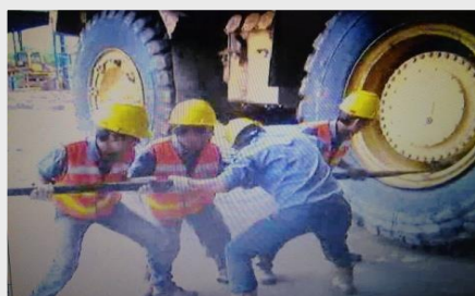
Gambar 7. Sebelum Perbaikan/Proses Manual Sumber : Perusahaan, 2021
